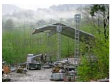
Garstige Bedingungen Tribünen- Aufbau in Giswil.
